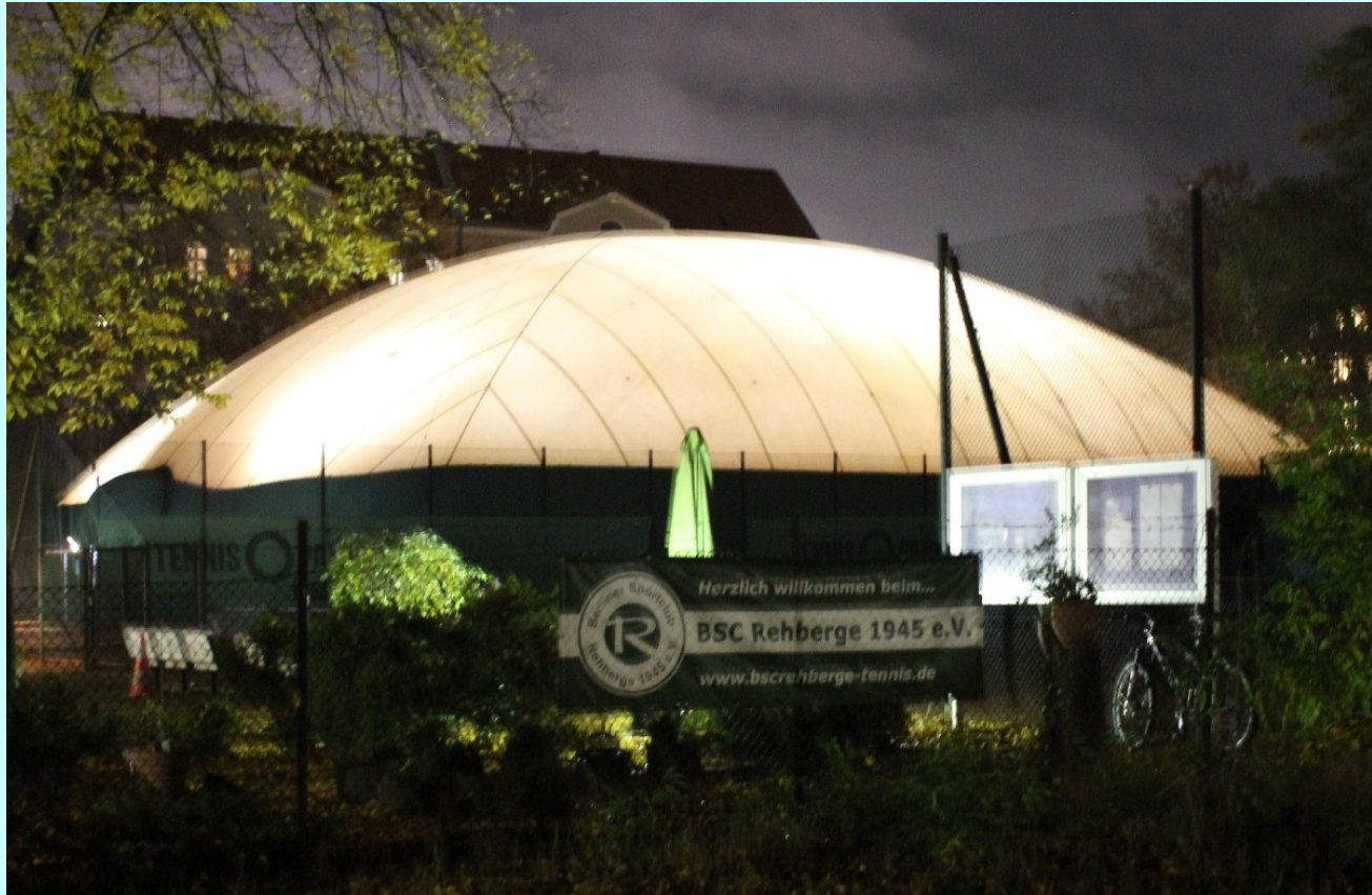
Abends - Ansicht von Außen nach Umstellung auf LED Beleuchtung
